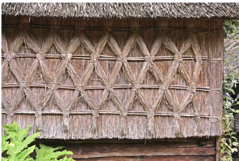
Figuur 16. Voorbeeld van een afwerking van riet met vlechtwerk op wanden.
