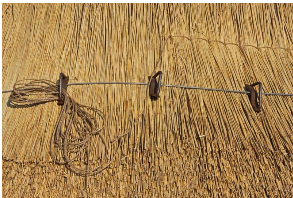
Figuur 18: Naaien van riet op een veld van de molenromp. Onder: bij de 1e arbeidsgang wordt het riet voorlopig vastgezet met een gaarde van dubbel gegalvaniseerd draad. Rechtsboven: bij de 2e arbeidsgang wordt het riet met molentouw (linksonder) genaaid op de rietlatten.
