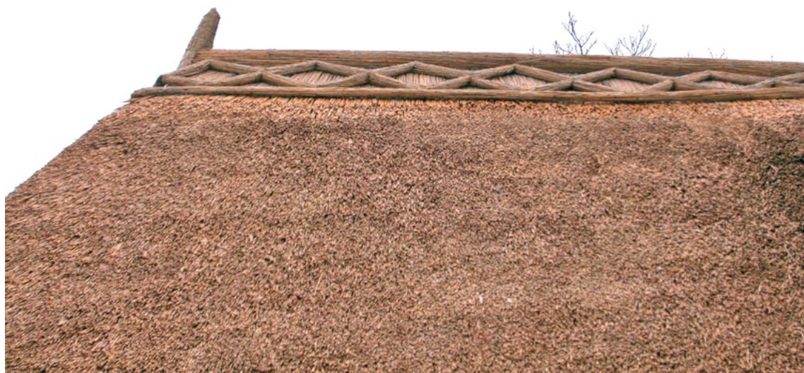
Figuur 7: Mogelijkheden voor het aanbrengen overgebonden vorst met rol en tuul of tuuf.
